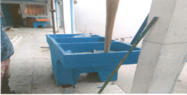
Foto 7: Sustrucción de pila de cemento de dos lavaderos recepción en el establecimiento para la colocación en el lugar asignado
