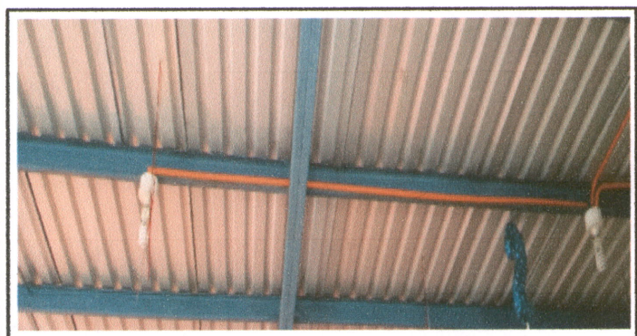
Foto 5: inicio de clolcación de ducto en aulas del establecimiento para la Reparación de sistema eléctrico
