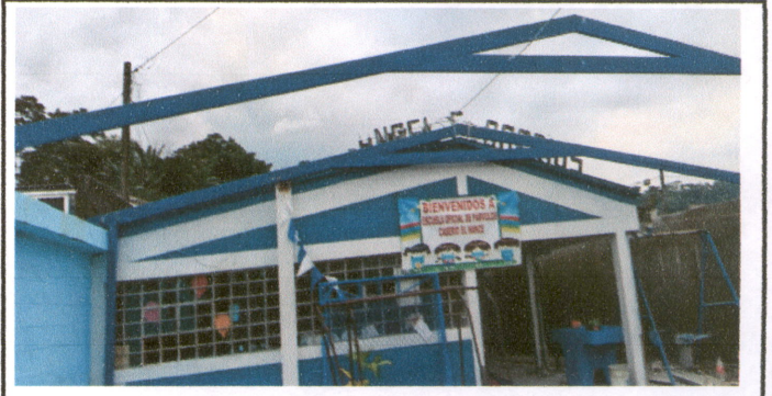
Foto 2: Avance de trabajo de sustitución de estructura de soporte de metal por metal, colocación de las primera tijeras de estructura portante para techado del patio del establecimiento.
